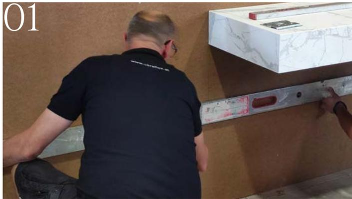
01 Höhe der oberen Bohrlöcher der Schwerlast-Grundplatte markieren und waagrechten Strich ziehen. **Achtung! Montagemaße beachten** → siehe Skizze S. 11 - 15
