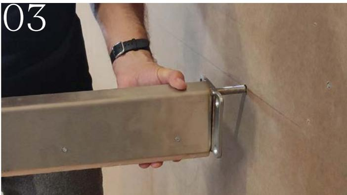
03 Löcher bohren (Ø 12,5 mm) und Konsolenträger einstecken. Achtung! Montageuntergrund beachten.
