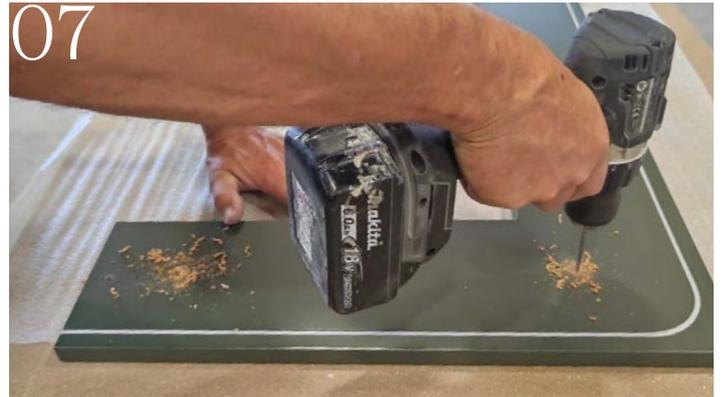
4 Stk. Bohrlöcher an entsprechender Position in die Untersicht bohren und ausreiben.
