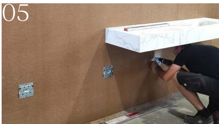
05 Grundplatten der Schwerlastträger montieren.
