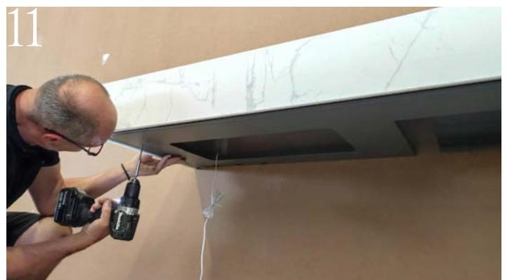
Abdeckplatte montieren und Beleuchtung anschließen.
