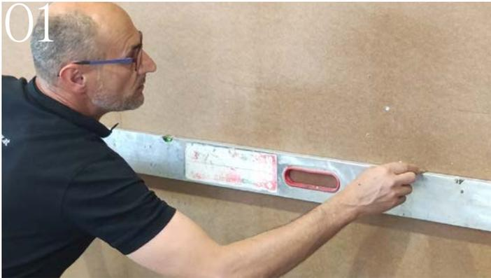
01 Montagehöhe der Konsolenträger markieren und mittels Wasserwaage einen waagrechten Strich ziehen.
