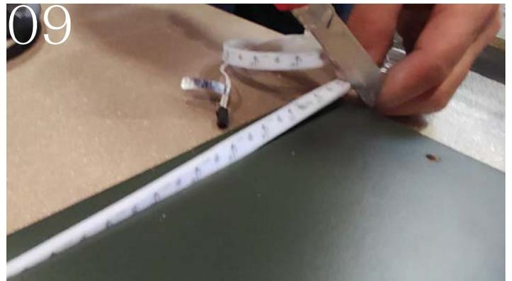
LED-Stripe auf benötigte Länge kürzen. (Bauseits vorbereitet: geeignete Elektroinstallation)
