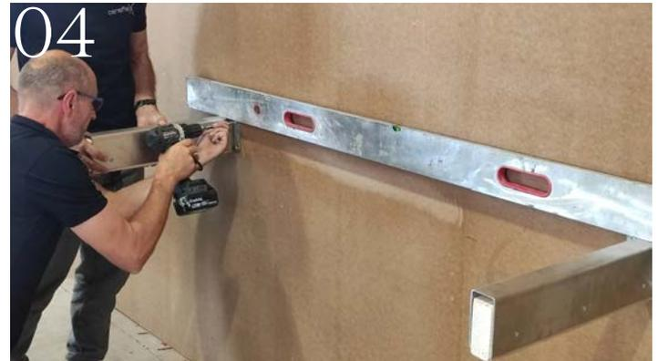
04 Konsolenträger mit jeweils 4 Schrauben fixieren. Befestigungsmaterial ist für massive Wände ausgelegt. Bitte Einbausituation prüfen und entsprechendes Befestigungsmaterial verwenden.
