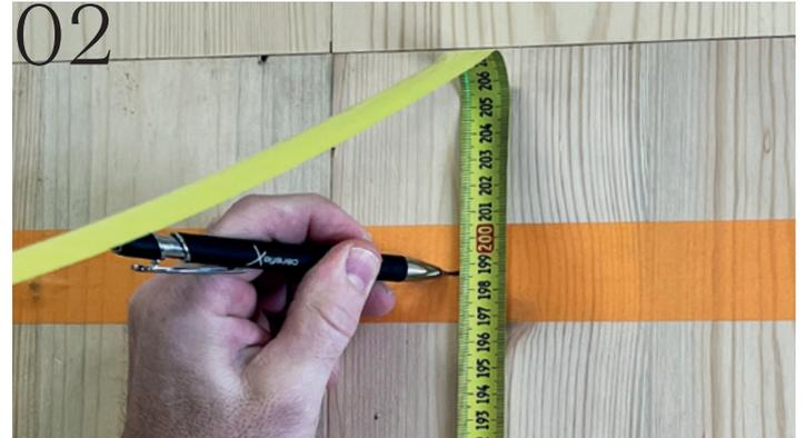
02 Mittels Laser oder Wasserwaage über dem Mittelpunkt die Höhe von 1988 mm\* (über OKFF) markieren und einen waagrechten Strich ziehen.
