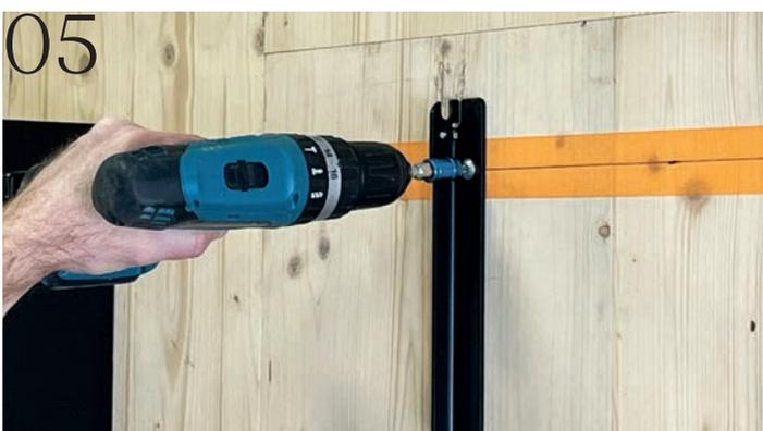
05 Beide Schienen mit dem ersten Schrauben fixieren.
