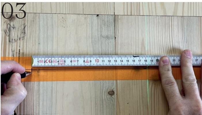
03 Vom Mittelpunkt auf beiden Seiten 185,5 mm vermessen, damit ein Abstand von 371 mm für die ersten beiden Bohrlocher entsteht.
